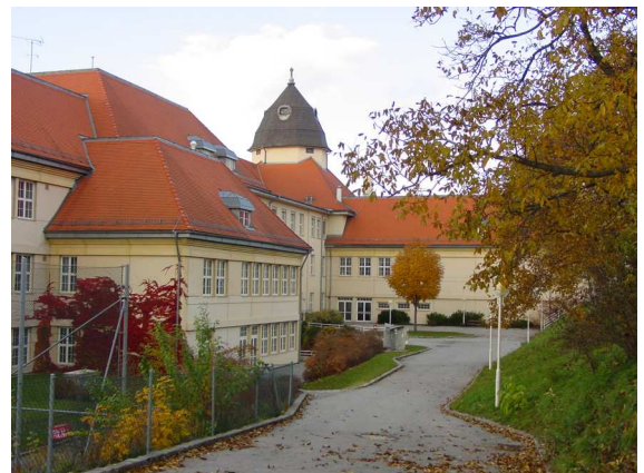
Zubau des BG/BRG
